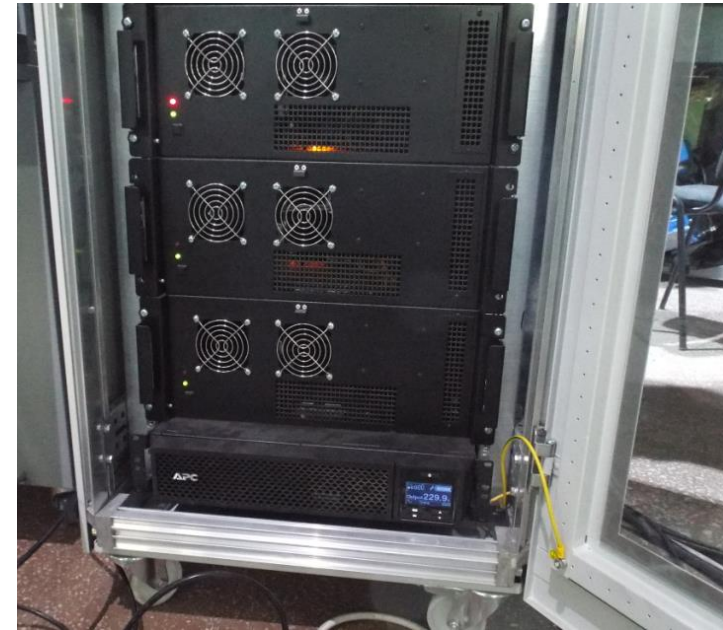
Комп'ютери та джерело безперебійного живлення в серверній шафі
